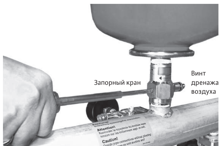
Рис. 2б Обслуживание мембранного бака и проверка давления его наддува
